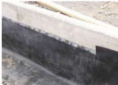
Une jonction en béton
