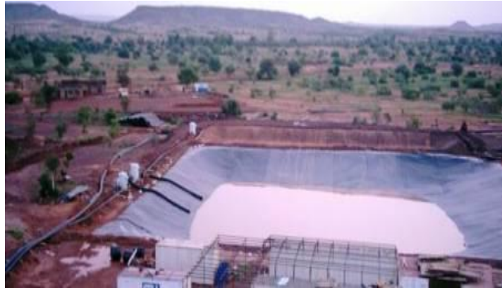
Bassin de nettoyage d'eau
