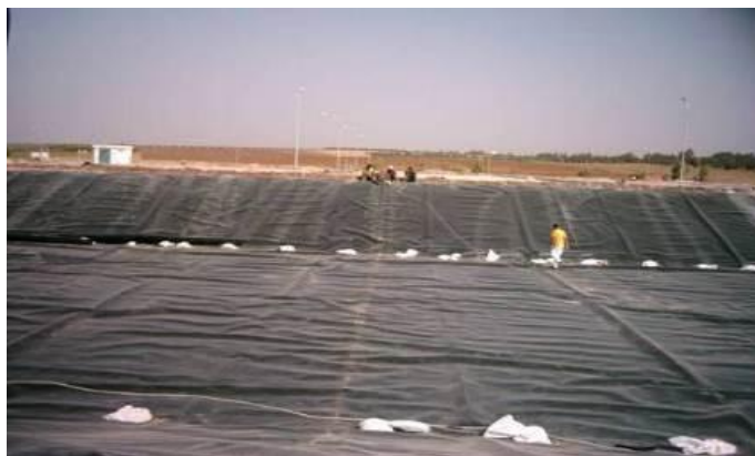
Bassin de maturation
